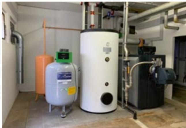
Remplacement de la chaudière du collège du Grand-Pont. Mise en œuvre d'un modèle à gaz
