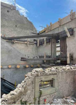
Démolition du bâtiment de la Balance, à l'exception des façades en maçonnerie. Etayage
