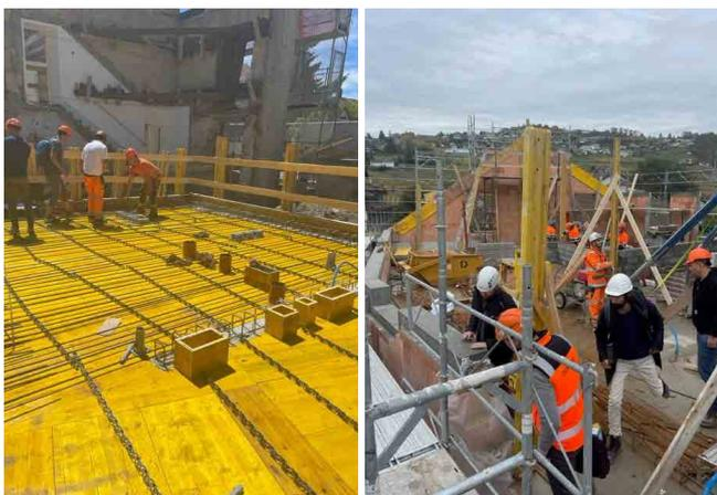
Coffrage pour mise en œuvre d'une partie de la dalle du rez-de-chaussée de l'extension
