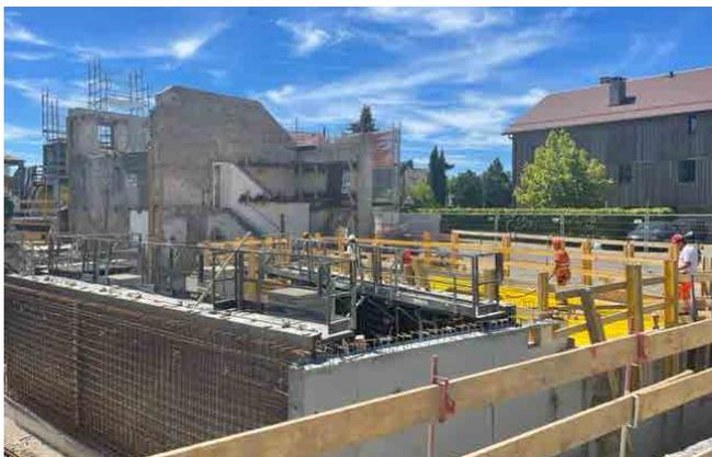
Mise en œuvre des murs (intérieurs et extérieurs) et des dalles de l'extension
