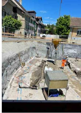
Mise en œuvre de canalisations sous les fondations de l'extension du bâtiment
