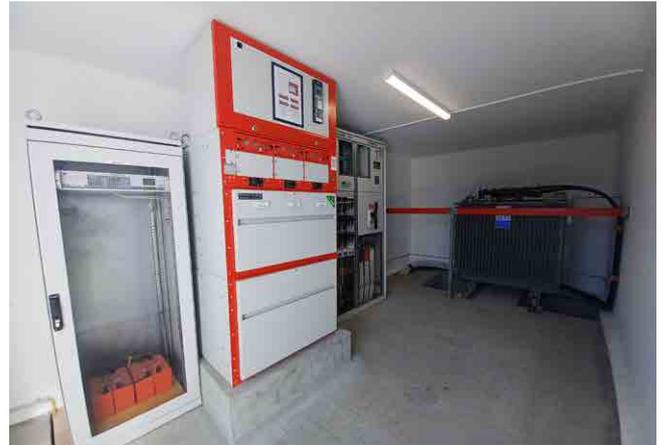
Station de Pontfilet, remplacement intégral des équipements MT et BT
