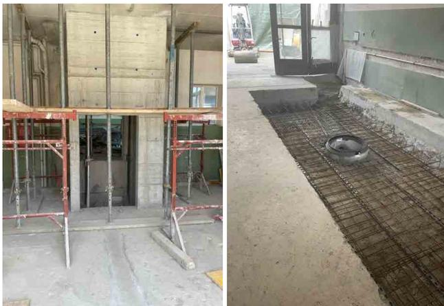
Mise en œuvre d'une trémie pour l'installation d'un monte-charges
