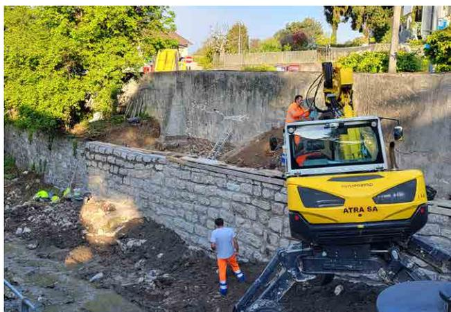
Réfection du mur de soutènement à la Lutrive
