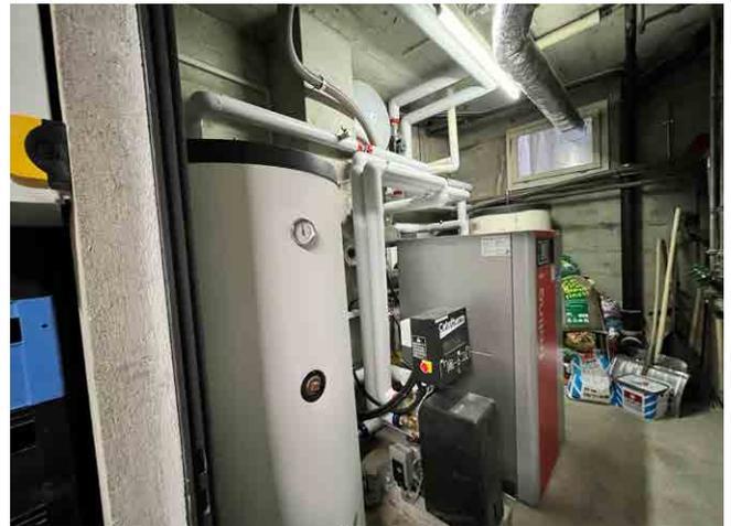
*Remplacement de la chaudière à mazout par une chaudière à pellets dans le bâtiment sis route de La Croix 241*
