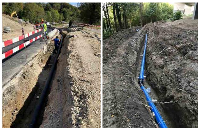
Rte des Monts-de-Lavaux, pose d'une conduite d'eau en PE DN 250 mm
