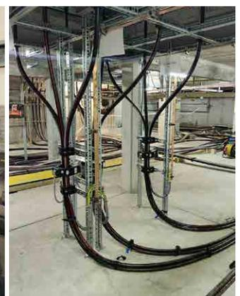
Station SILy, raccordement du réseau 12'000 V sous les cellules MT
