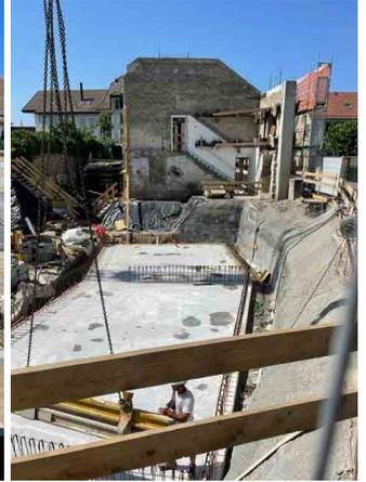
Mise en œuvre d'une partie du radier de l'extension du bâtiment
