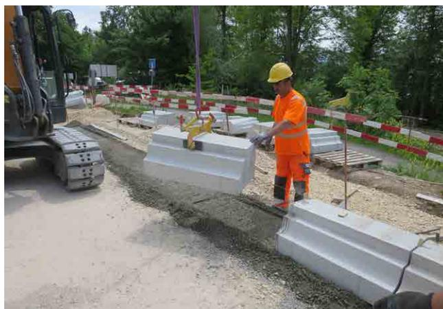
Pose des bordures adaptées LHand à l'arrêt t-l d'Echerins
