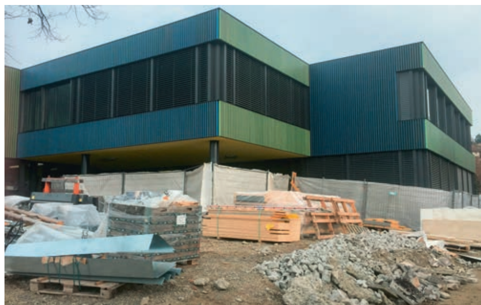
Travaux de rénovation au collège des Pâles.
