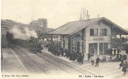
l'électricité est déjà arrivée à Lutry, comme en témoigne le pylône électrique installé sur le toit de la gare. Côté Est, la ligne part en direction des vignes en passant par d'autres relais. Sur la façade Ouest de la gare, des isolateurs en porcelaine installés sous le faîte du toit montrent que le précieux courant circule aussi vers Lausanne.
