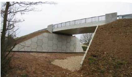
Le procédé de la terre armée, ou sol renforcé, est basé sur l'association d'un remblai compacté et d'éléments préfabriqués.
