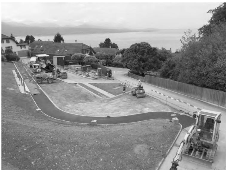
L'abri bus existant a été récupéré et replacé sur le nouveau trottoir. De par sa géométrie, ce nouvel aménagement évite tout ouvrage de soutènement (murs, gabions, terre armée) ce qui présente un avantage de sécurité non négligeable pour les élèves.
