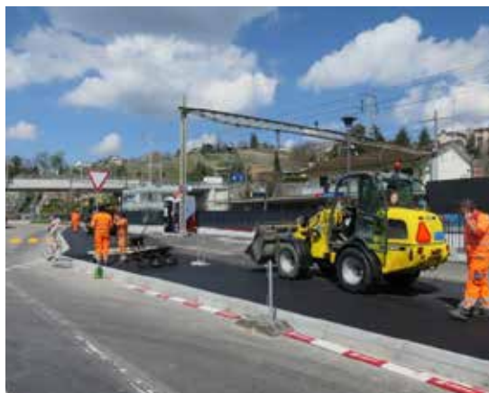
Réalisation d'un trottoir à la gare de la Conversion
