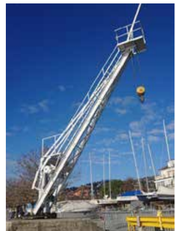
Inspection de la grue du port
