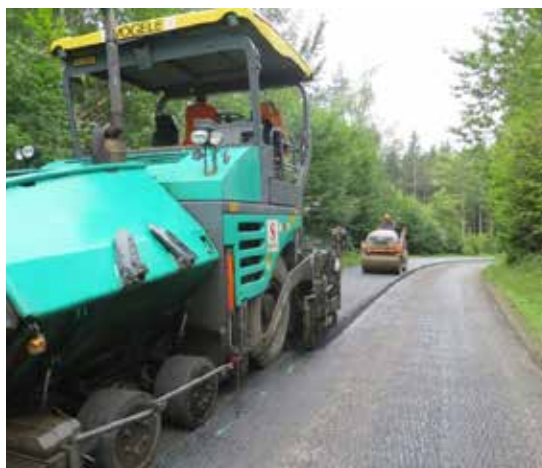
Réfection de la couche de roulement au chemin de Praz-Ballin
