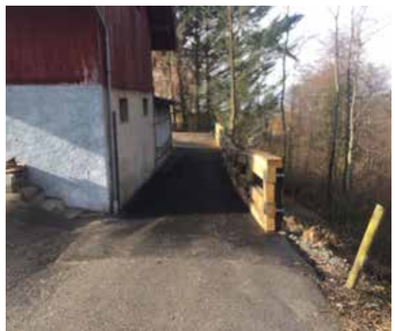
Route des Monts-de-Lavaux 335 Stabilisation de la parcelle
