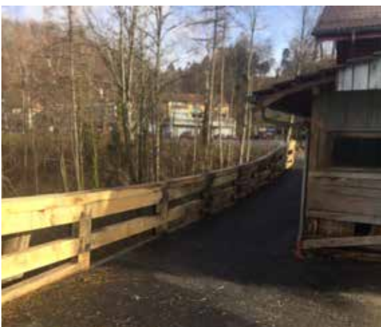
Route des Monts-de-Lavaux 335 Stabilisation de la parcelle
