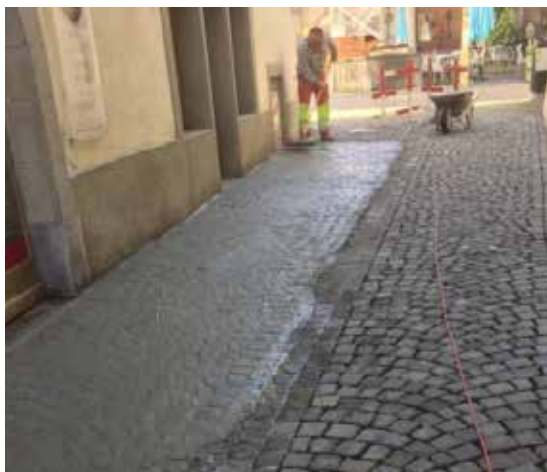
Travaux à la rue des Tanneurs
