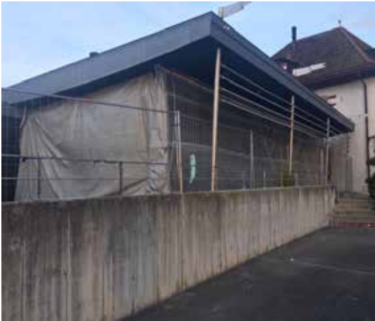
Route d'Ouchy 15 Remplacement des façades en serrurerie de la véranda
