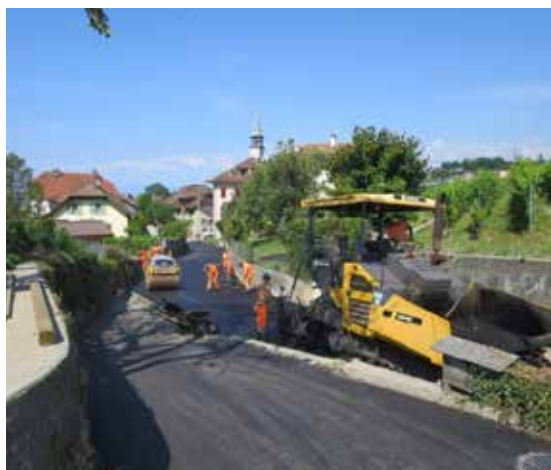
Réfection du revêtement à la route de Bossière
