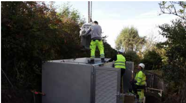
Remplacement de la station MT « la Croix » au chemin du Miroir
