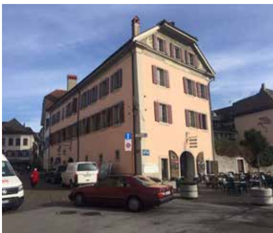
Place des Halles 1-3/Grand-Rue 24-26 Remplacement des volets
