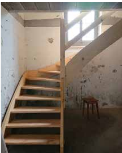
Construction d'un escalier au dépôt des ancien abattoirs
