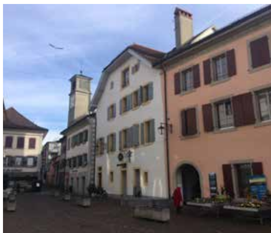
Place des Halles 1-3/Grand-Rue 24-26 Remplacement des volets
