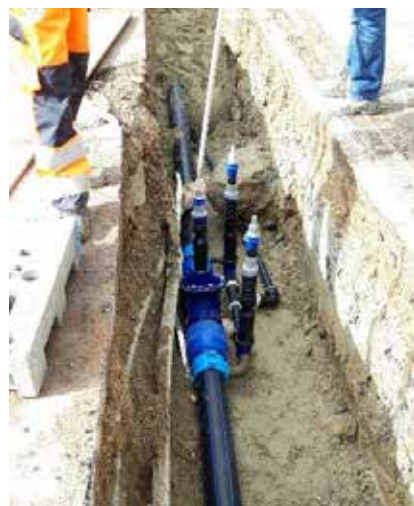
Remplacement conduite d'eau
