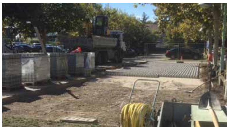
Travaux d'assainissement au parking de la Combe
