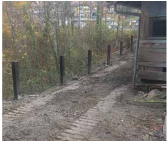
Route des Monts-de-Lavaux 335 Stabilisation de la parcelle
