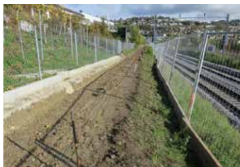
Travaux au secteur Blanchette
