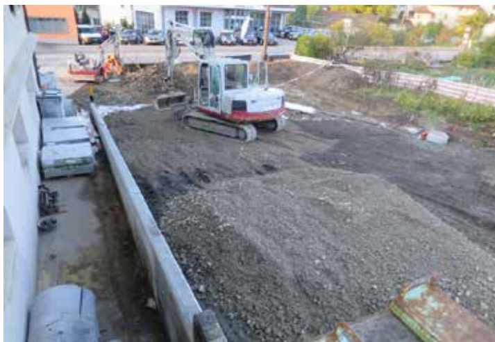
Construction de nouvelles places de parc à la voirie
