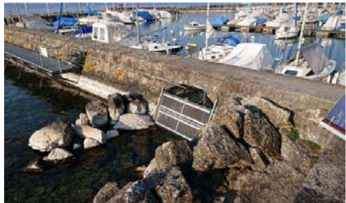
Remplacement de la grille
