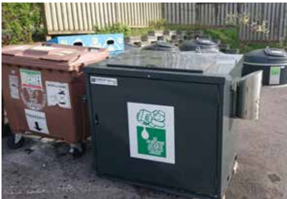
Remplacement et modification d'un réceptacle à huiles usagées
