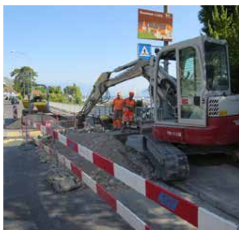
Travaux d'installation d'une signalisation lumineuse à la route d'Ouchy
