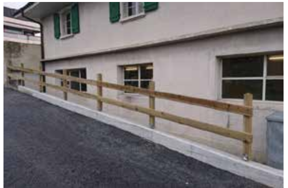
Construction d'une barrière pour le bâtiment de la voirie
