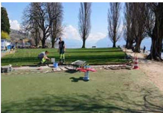
Mise à niveau du dallage de la buvette et chemins de la Plage de Curtinaux
