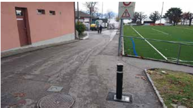
Scellement d'une borne amovible au préau du Grand-Pont
