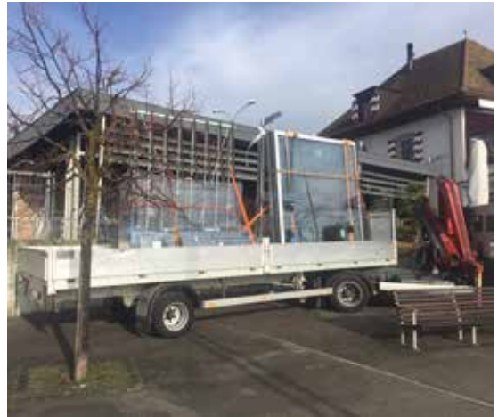
Route d'Ouchy 15 Remplacement des façades en serrurerie de la véranda
