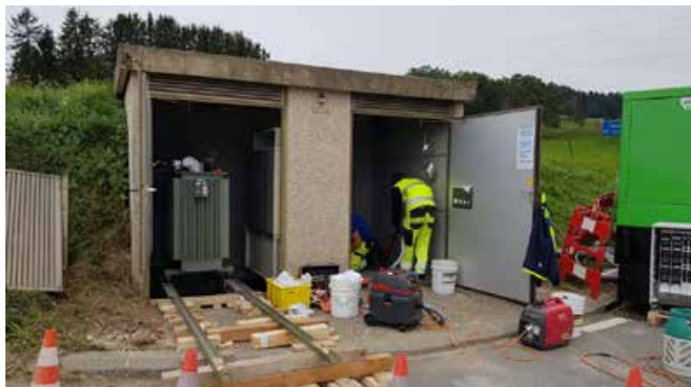
Remplacement du transformateur et du tableau BT à la station Crêt-Ministre
