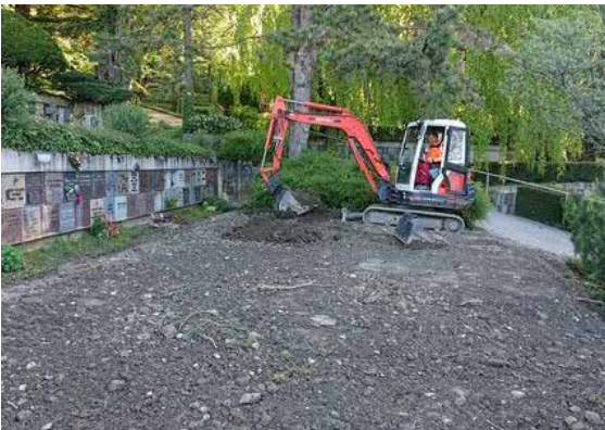
Étanchéité de la dalle du jardin du souvenir
