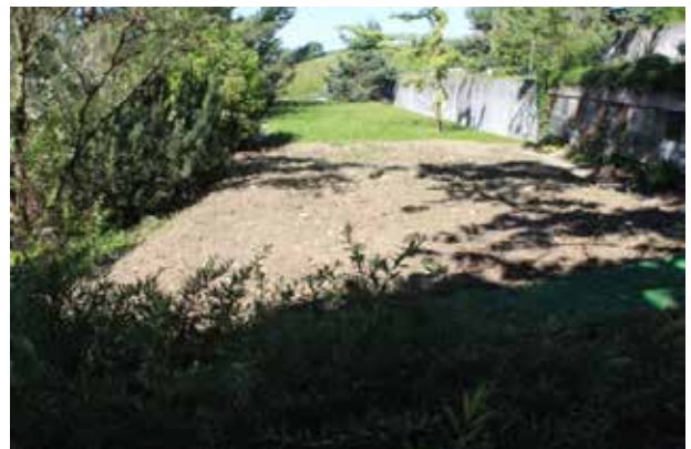
Travaux de désaffectation
