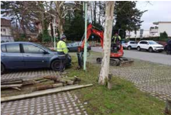
Parking de la Combe - Remplacement des clôtures
