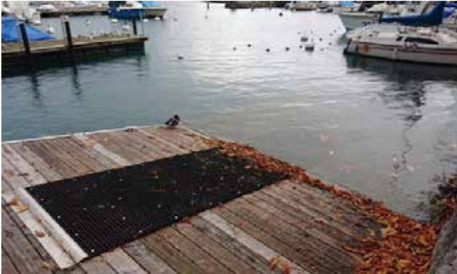
Réfection des caoutchoucs de la rampe à bateau
