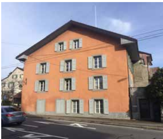
Rue du Voisinand 2 (S.I.) Remplacement des fenêtres en bois
