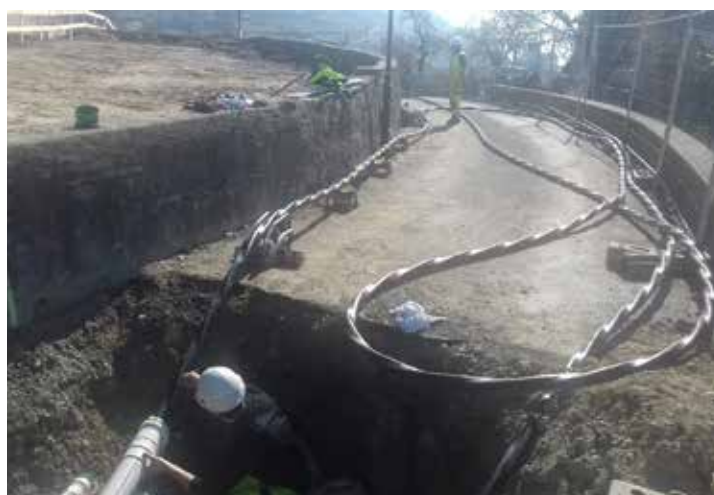
Déournement de la ligne MT au chemin de Bertholod
