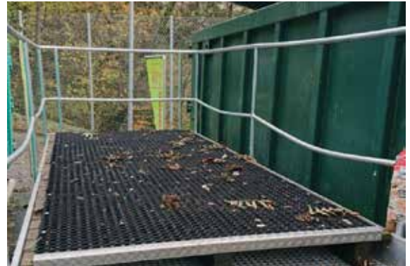
Pose d'un revêtement antiglisse sur une passerelle de la déchetterie
