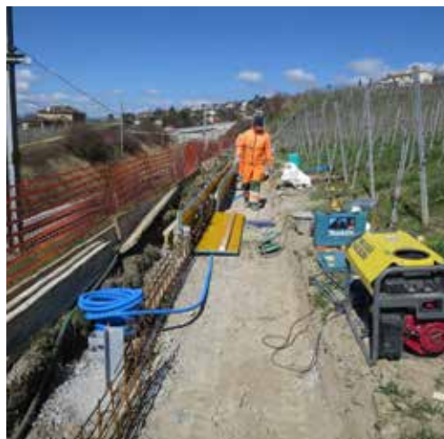
Travaux au secteur Bossière Nord
