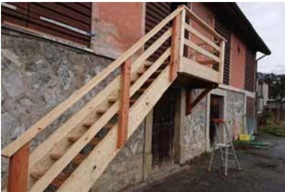
Remplacement de l'escalier du dépôt du jardin du Grand-Pont
