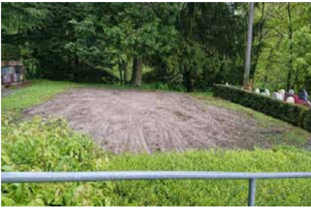
Travaux de désaffectation
