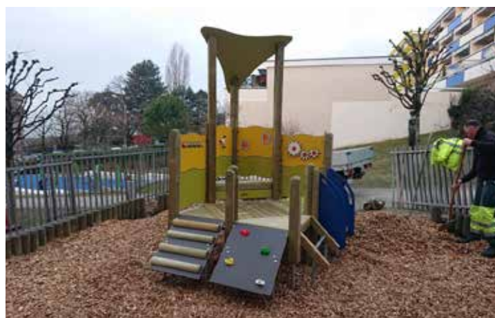
Remplacement d'un équipement
