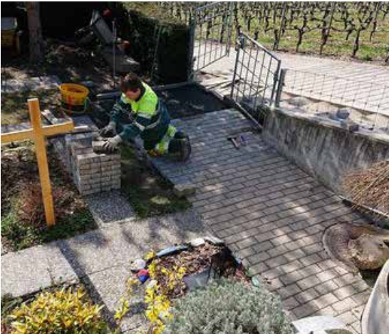
Aménagement par les apprentis d'une entrée pavée
