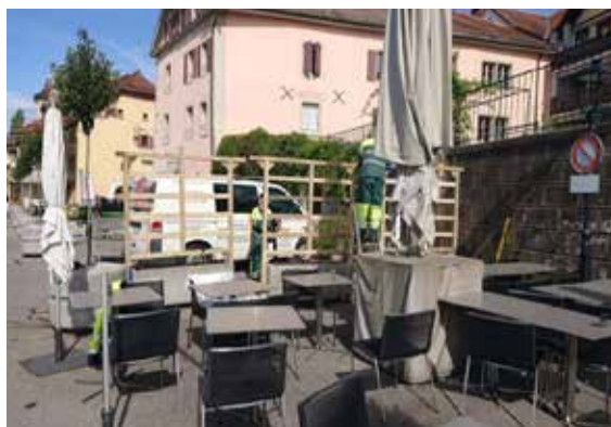
Remplacement de la végétation des bacs au Quai Doret
