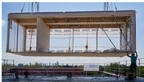
Fig. 5 : Exemple d'une classe modulaire préfabriquée en usine. Levage et montage rapide sur chantier avec un camion-grue.
