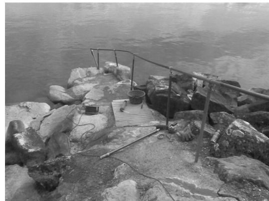
Main courante digue plage
