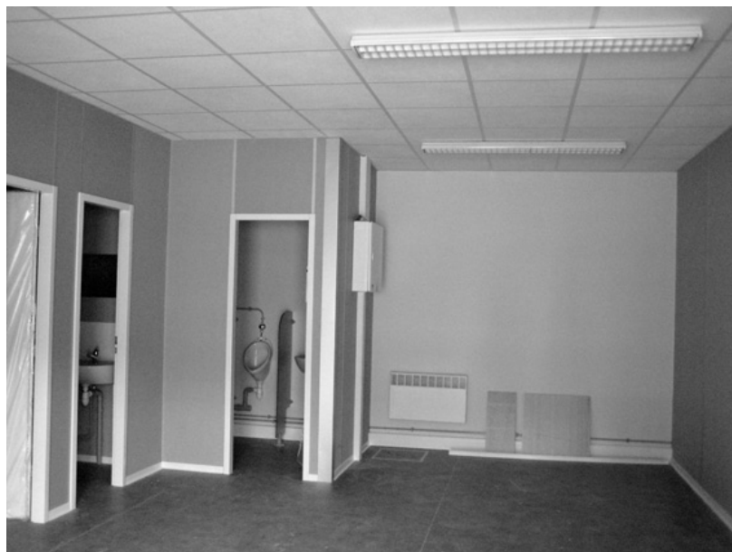
Etat après remplacement des modules sinistrés
