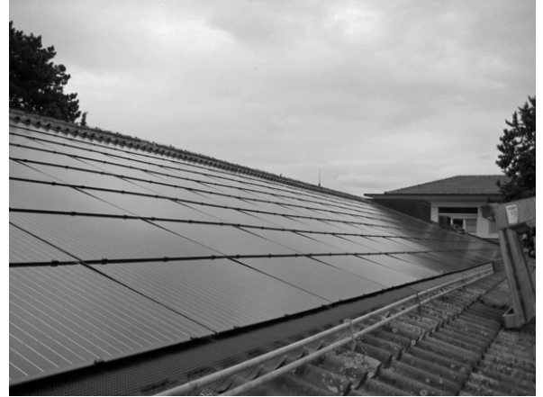
Salle de gymnastique du Grand-Pont : mise en place d'environ 150 m 2 de panneaux photovoltaïques
