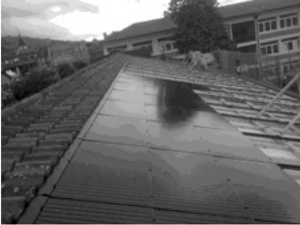
Salle de gymnastique du Grand-Pont : mise en place d'environ 150 m 2 de panneaux photovoltaïques
