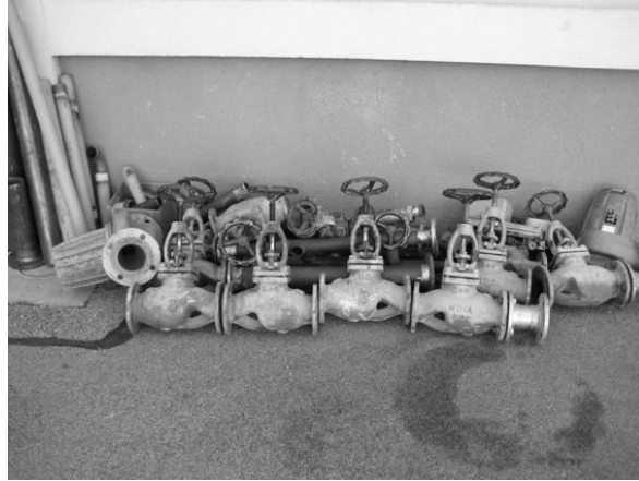
Collège du Grand-Pont : remplacement des vannes de chauffage
