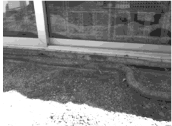
Restaurant La Lagune – Racine ayant provoqué la déformation du vitrage coulissant de l'annexe Ouest
