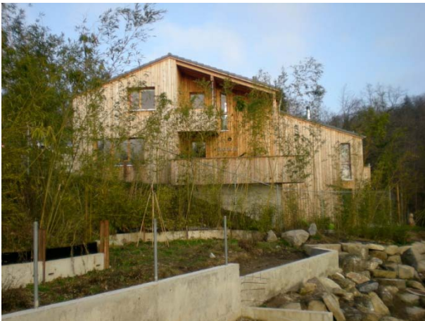
Sentier d'En Vaux : villa locative de 2 appartements
