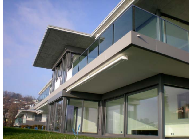
Rte de Crochet : immeuble de 2 appartements
