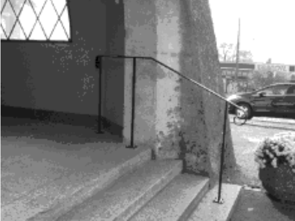
Eglise catholique St-Martin Lutry/Paudex Main courante au bas de l'escalier
