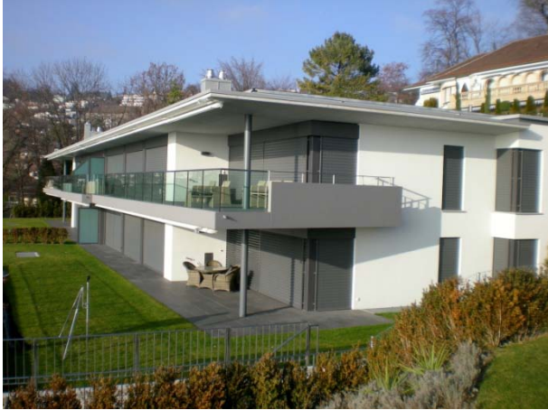
Rte de Crochet : immeuble de 4 appartements
