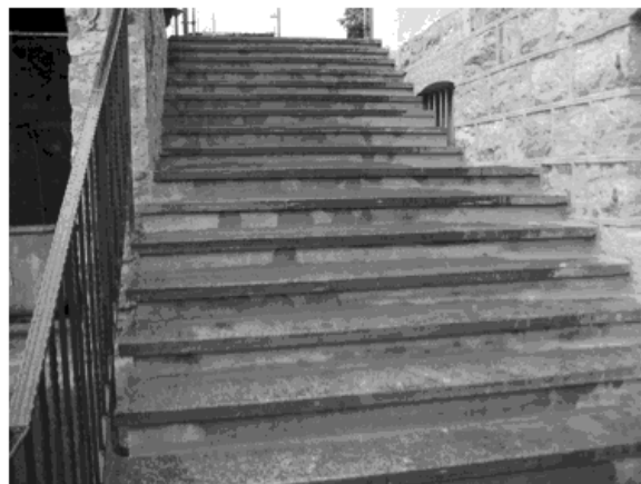
Collège de Savuit – Escalier d'accès après la réfection
