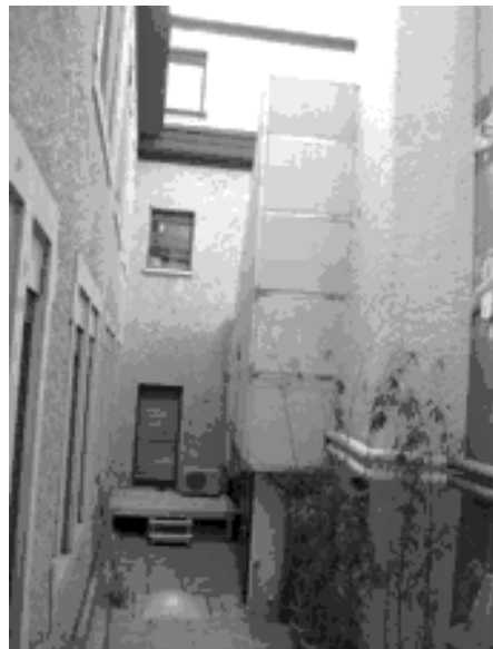
Hôtel Le Rivage – Cour intérieure Paroi phonique terminée
