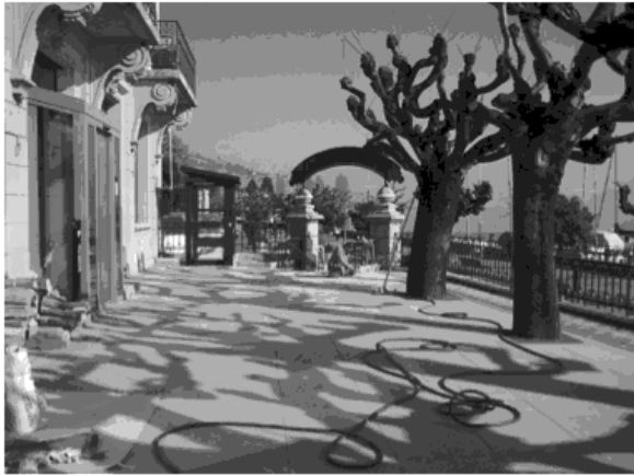
Hôtel Le Rivage – Nouveau sol sur la terrasse
