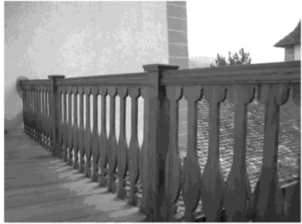
Château – Nouvelle barrière du balcon au 2 ème étage
