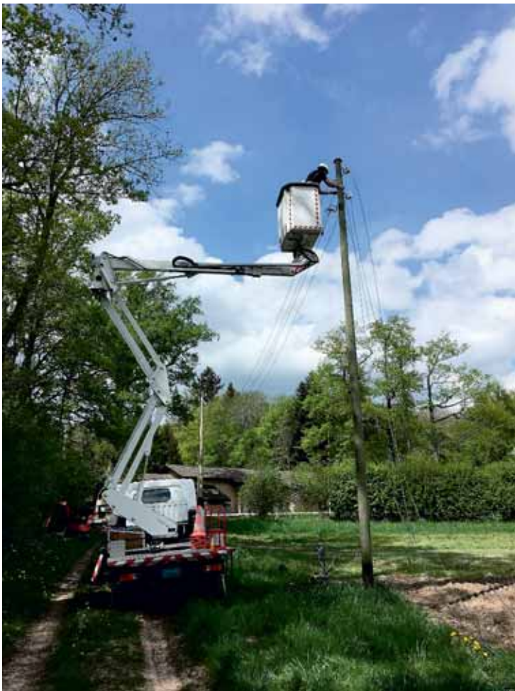
Dépose de la ligne aérienne à la Grangette
