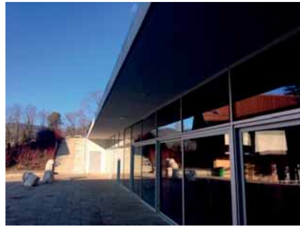
Complexe scolaire de La Croix-sur-Lutry (réfection du complexe isolation/étanchéité, réhabilitation de la marquise)
