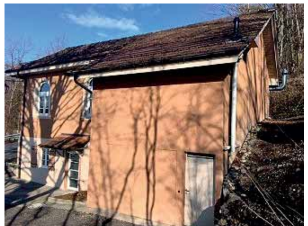
Salle d'Echerins (réalisation d'un complexe de drainage en façade Est)
