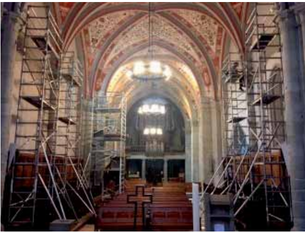
Temple (mise en œuvre d'un nouvel éclairage)
