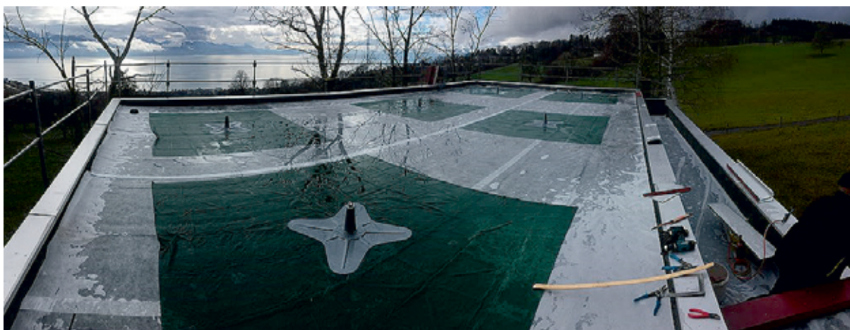
Etanchéité du toit du réservoir des Echerins
