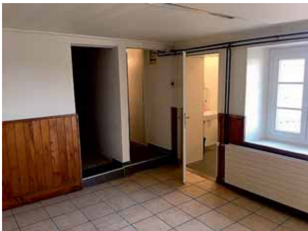
Salle d'Echerins (réhabilitation des W-C, accessibilité depuis l'intérieur de la salle)
