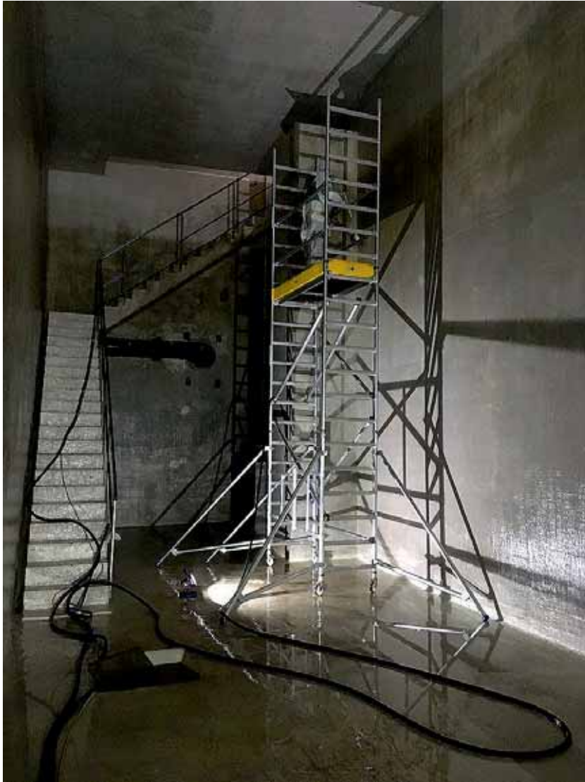
Nettoyage du réservoir des Echerins
