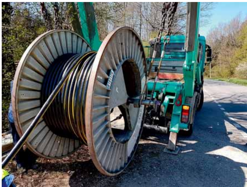
Dépose de la ligne aérienne à la Grangette : char de pose à Chanoz-Brocard
