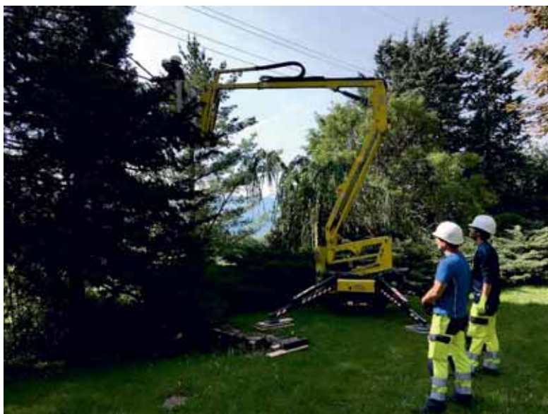
Elagage de lignes MT/BT sur domaine privé au moyen d'un engin spécial loué à cet effet.
