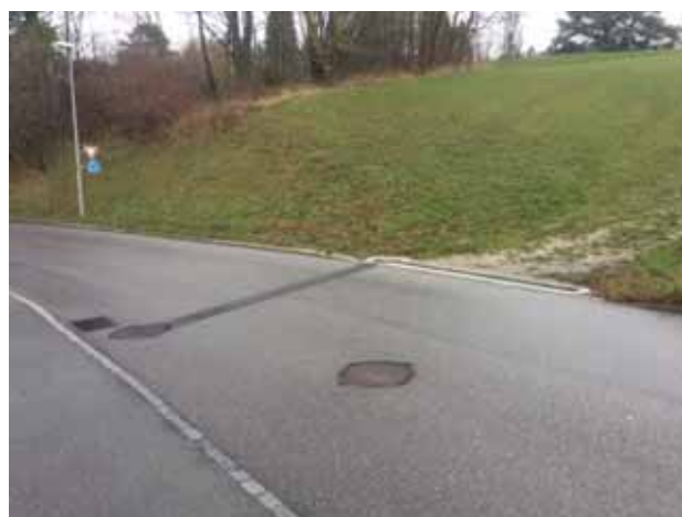
Signal de Bochat - Pose d'un caillebotis
