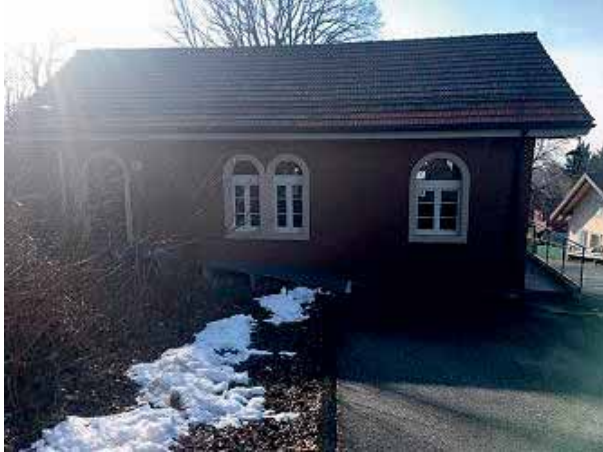
Salle d'Echerins (reconstruction de la façade suite sinistre)
