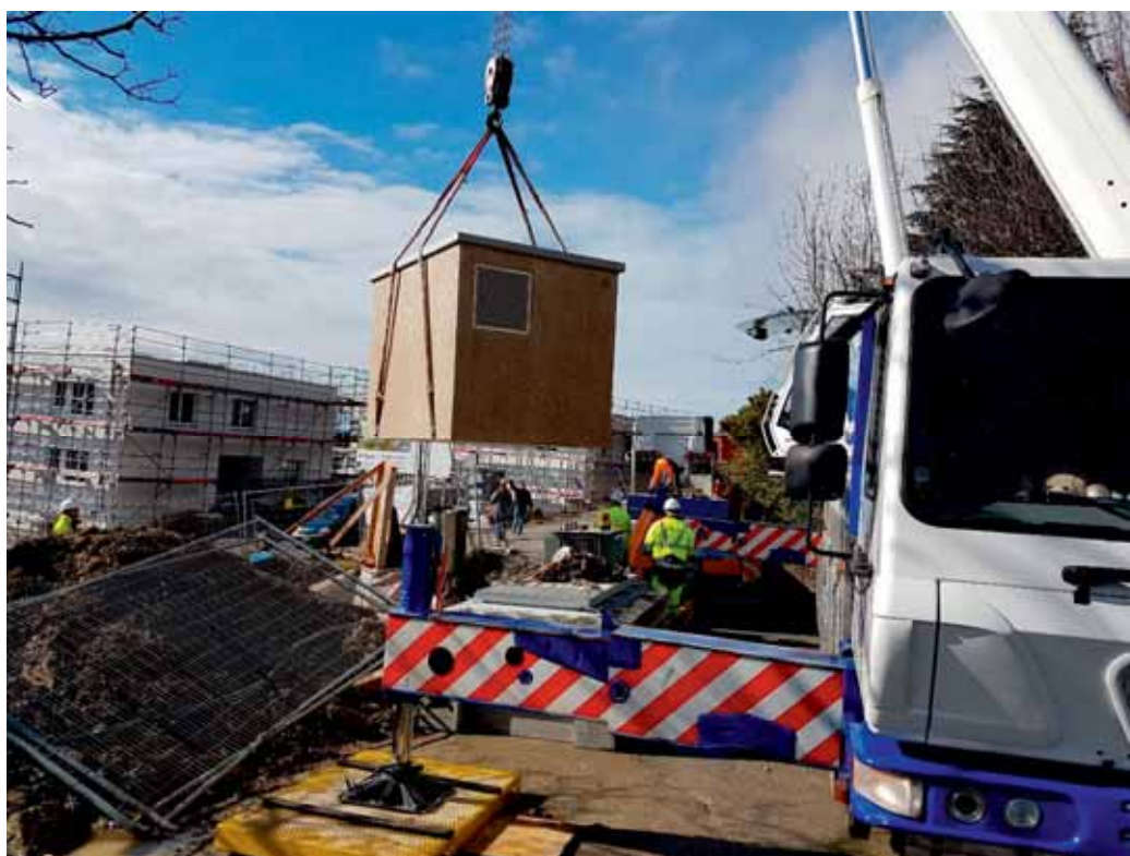
Installation de la sous-station « Brûlées » en mars 2018
