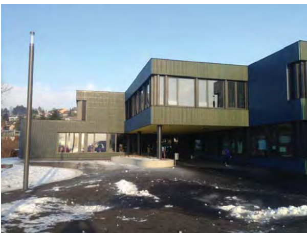
Aménagements extérieurs complexe des Pâles
