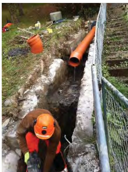
Remplacement d'une ancienne coulisse
