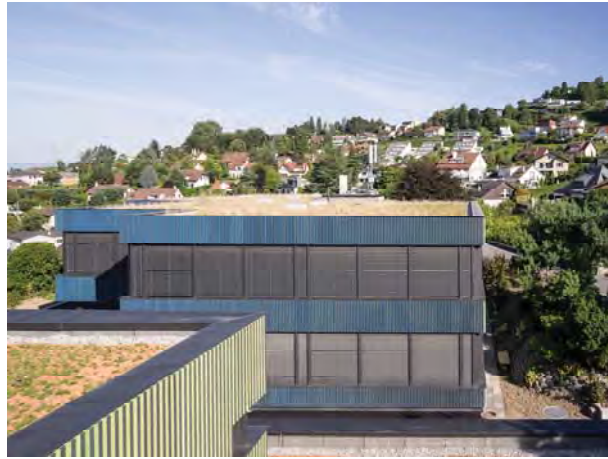
Vue des toitures végétalisées
