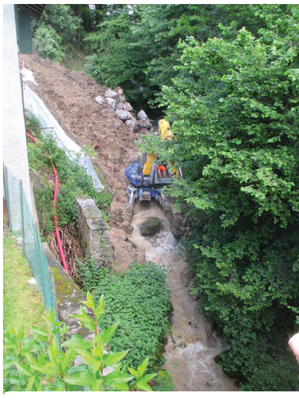
Photo des travaux de juin 2016
