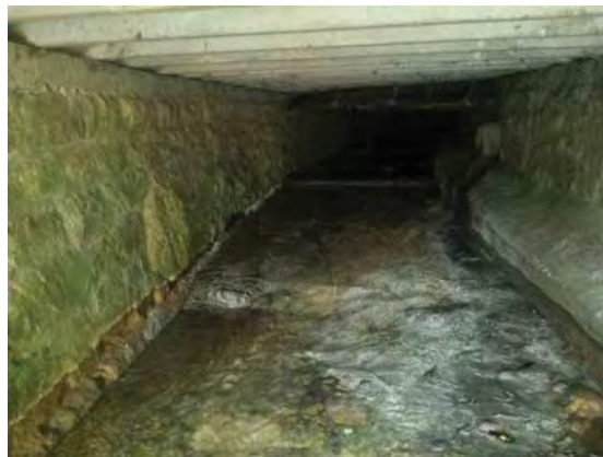
et après travaux
