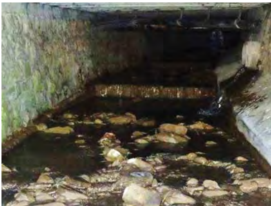
Situation avant travaux
