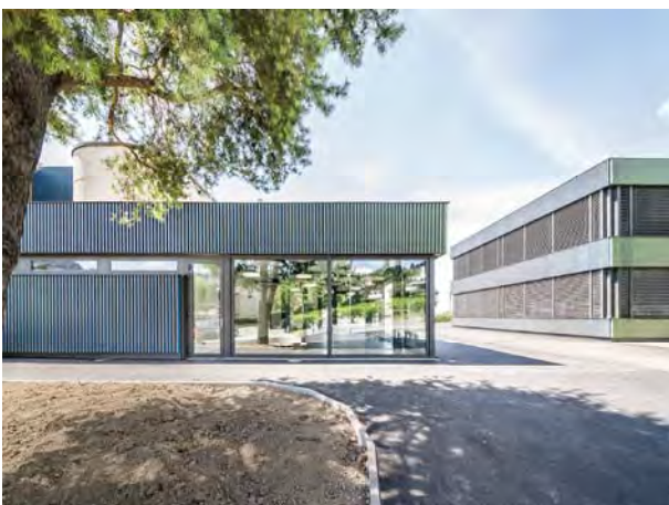
Vue sur l'extension de la nouvelle cafétéria
