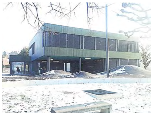
Façade Sud bâtiment des Pâles 1
