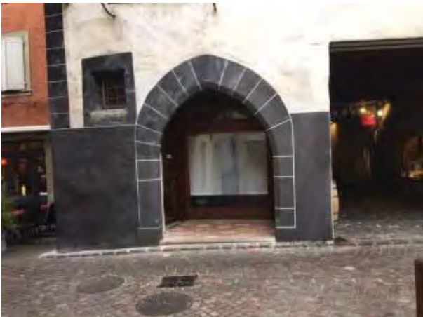
Réfection encadrement entrée rue du Simplon
