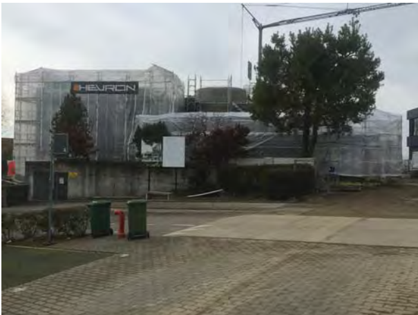
Chantier 2ème étape : bâtiment des Pâles 1
