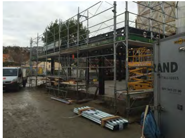
Chantier 2ème étape : bâtiment des Pâles 1
