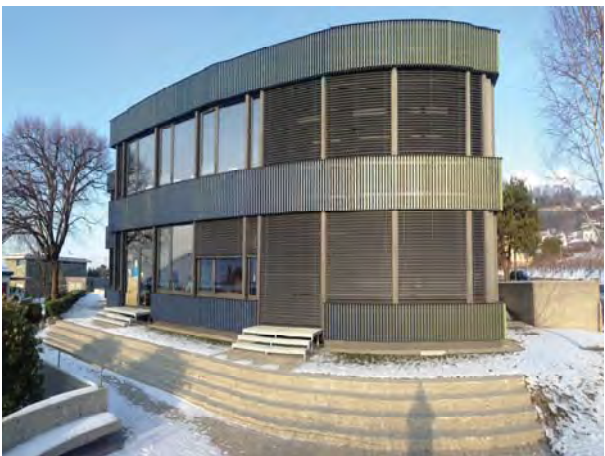
Façade Ouest bâtiment des Pâles 1
