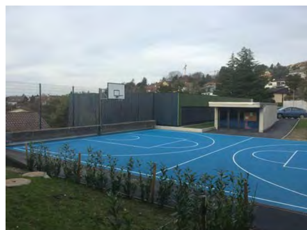
Aménagements extérieurs complexe des Pâles
