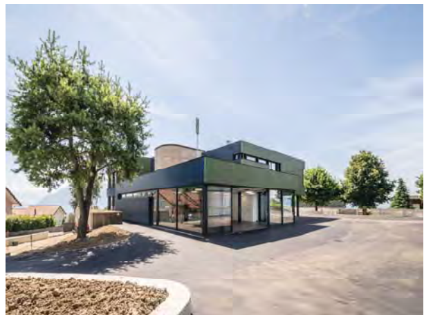
Façades Nord et Est bâtiment des Pâles 1
